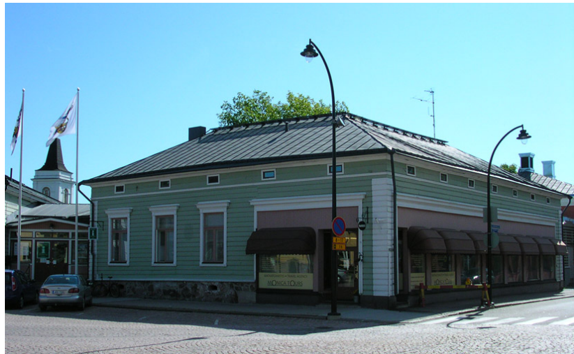
Kuva 2. Suunnittelualueella sijaitseva rakennus, nk. Haminan Vanha Rautakauppa.
